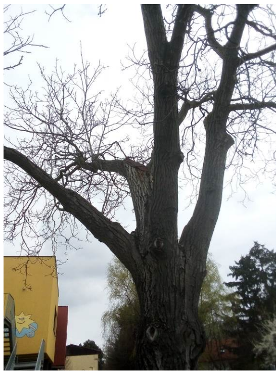
Obr 3: Detail zastřešení dutiny v koruně
